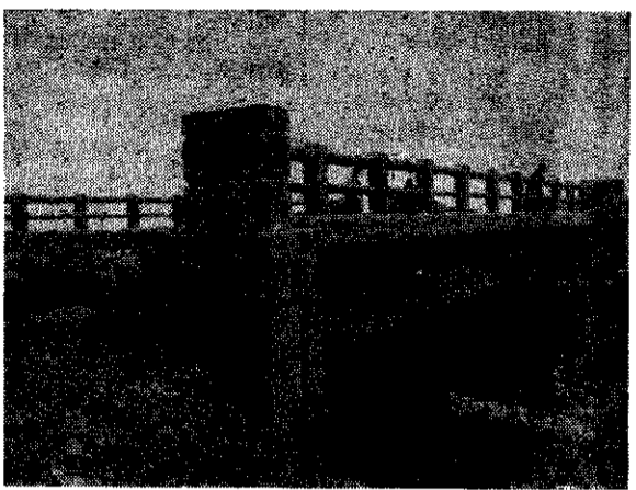
完成した尾野瀬橋
