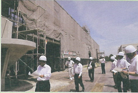
平成28年4月に開校する 甘楽中学校建築現場
