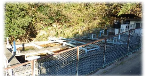
轟浄水場（沈殿池）
