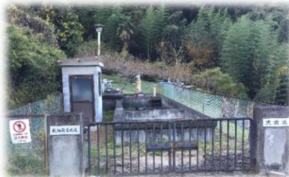
来波浄水場（沈殿池）
