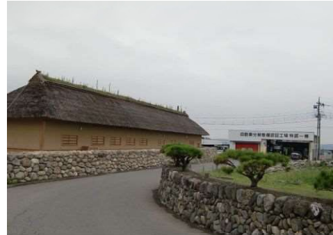
■ 建築規制をしていないため拾九間長屋 (名勝楽山園内)北に建つ自動車修理工場
