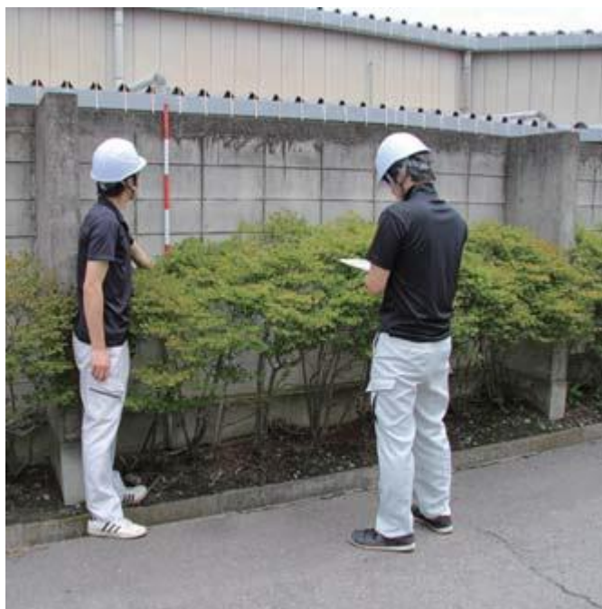
写真4 - 1 : ブロック塀等の安全点検の様子
