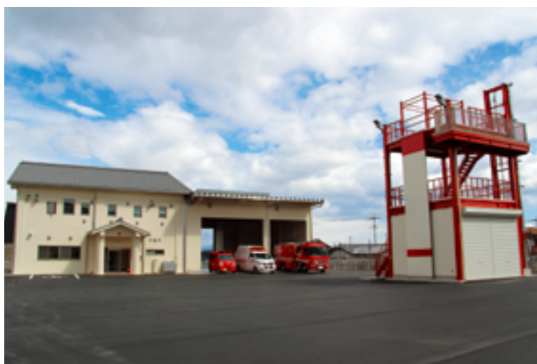
消防再編計画により移転整備された甘楽分署
