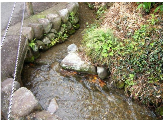
4. 矢羽橋分水路
