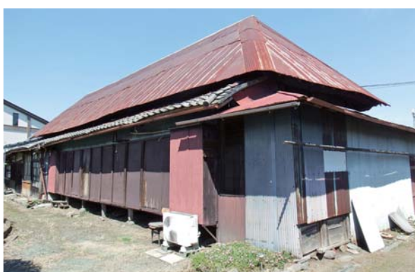
長屋建物の現状は長さ約22m、幅約10m、高さ約6m
