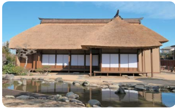
歴史的建造物の保存とまちなみの景観を向上するため整備された「旧小幡藩武家屋敷松浦氏屋敷」
