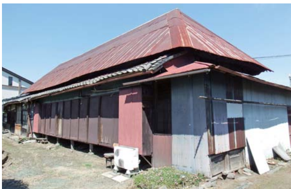
長屋建物の現状は長さ約22m、幅約10m、高さ約6m
