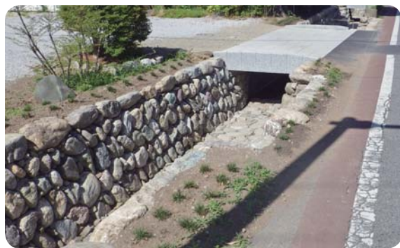
町の歴史的風致の中核をなす「雄川堰」の保存活用を図るため石積みを修繕
