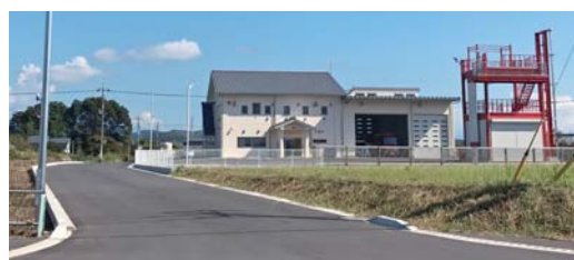
新設された町道管溝2号線
