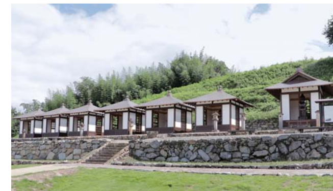
元年度に完了した織田氏七代の墓御霊屋修景施設整備工事
