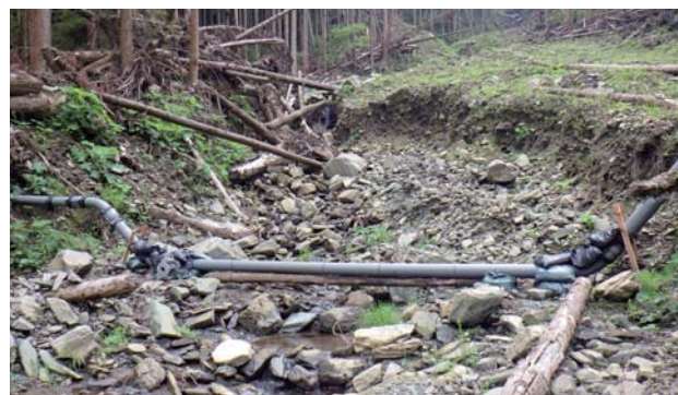
芳の元導水管災害復旧応急仮工事（秋畑）
