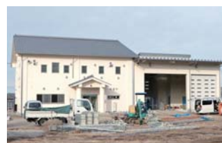
建設工事が進む甘楽分署
